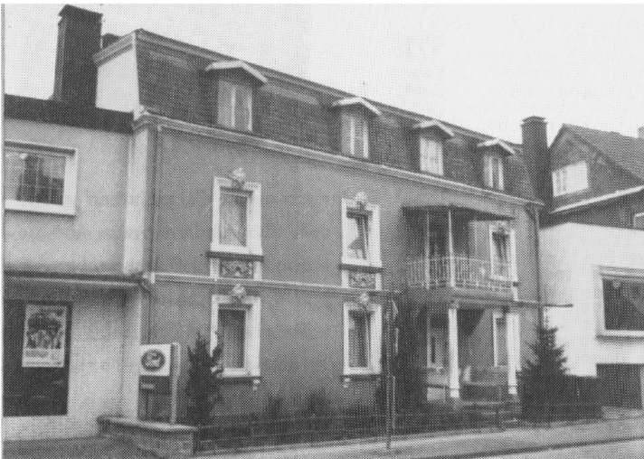
Ehemaliges Wohnhaus Tiemann, Wickede, Ringstraße
