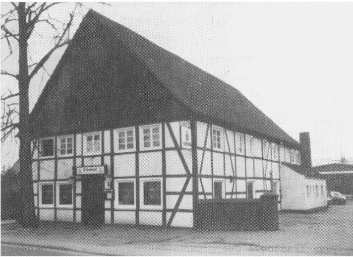
Besitzung Siedhoff (Gaststätte Erlenhof) (gehört zu den alten Hofstellen in Wickede)
